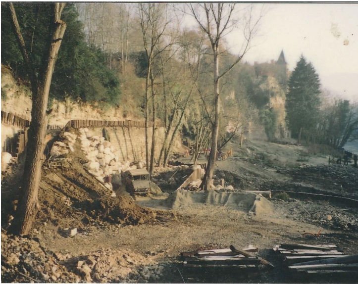
Le début des travaux en 1994
